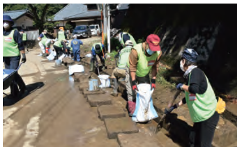
温泉街の側溝を埋めた泥と格闘するボランティア＝関川村湯沢
