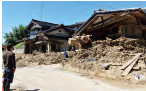
土石流に直撃され、被害のすさまじさを伝える民家＝村上小岩内
