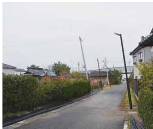
▲電柱が大きく傾いたままの被災地＝2月1日、新潟市西区善久
