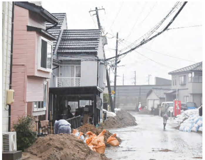
液状化の甚大な被害を受けた新潟市西区善久の一角。一帯の民家や電柱は傾き、電線もたわんだ＝1月6日
