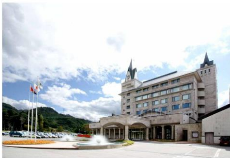
〔ロイヤル胎内パークホテルの外観〕
